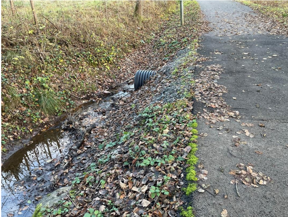
Figur 8. Trumma under befintlig cykelväg väster om planområdet. Bild från platsbesök 2023-11-15.
