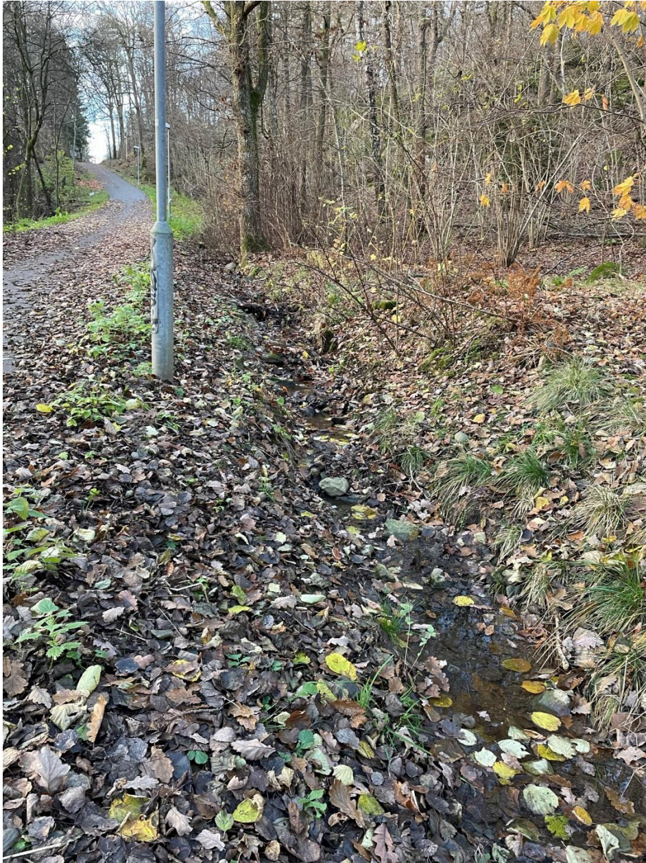
Figur 7. Dike längs med befintlig cykelväg väster om planområdet. Bild från platsbesök 2023-11-15.
